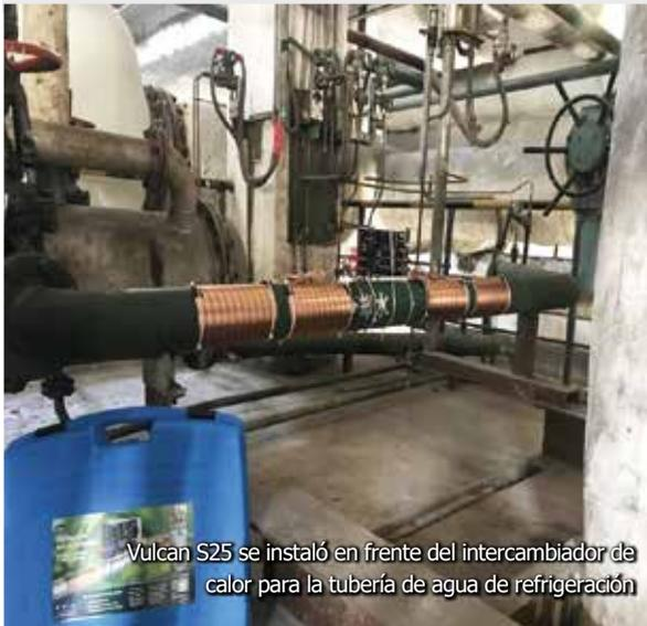
Vulcan S25 se instaló en frente del intercambiador de calor para la tubería de agua de refrigeración
