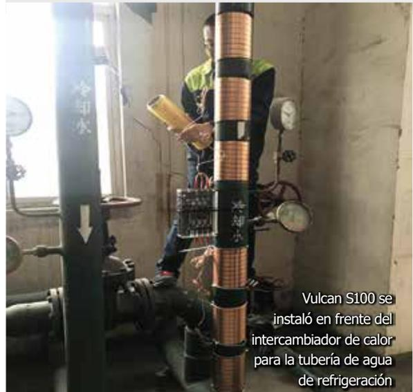
Vulcan S100 se instaló en frente del intercambiador de calor para la tubería de agua de refrigeración
