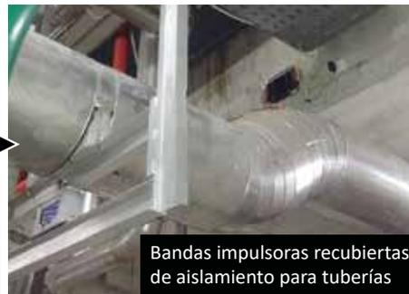
Bandas impulsoras recubiertas de aislamiento para tuberías
