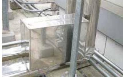
Se instaló un equipo Vulcan S25 en la tubería de agua de las torres de refrigeración A, B y C.
