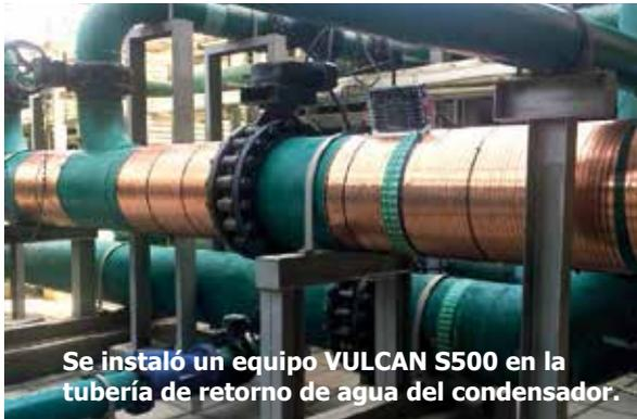
Se instaló un equipo VULCAN S500 en la tubería de retorno de agua del condensador.
