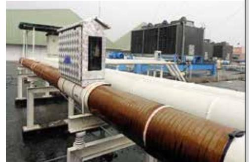
Vulcan S500 se ubicó dentro de una caja de aluminio y se instaló en la tubería principal de una torre de refrigeración en el centro comercial Karawaci.
