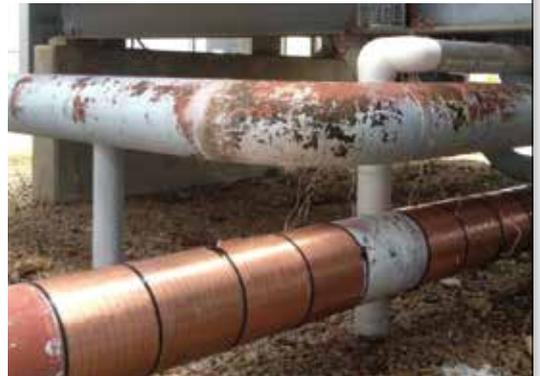
El equipo Vulcan S250 fue instalado en la tubería de 10" de diámetro que alimenta las torres de refrigeración gemelas (CT-1 y CT-2).
