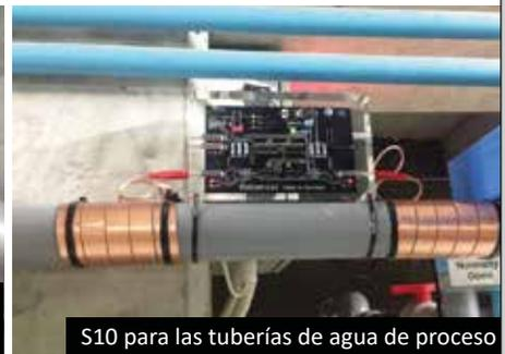
S10 para las tuberías de agua de proceso
