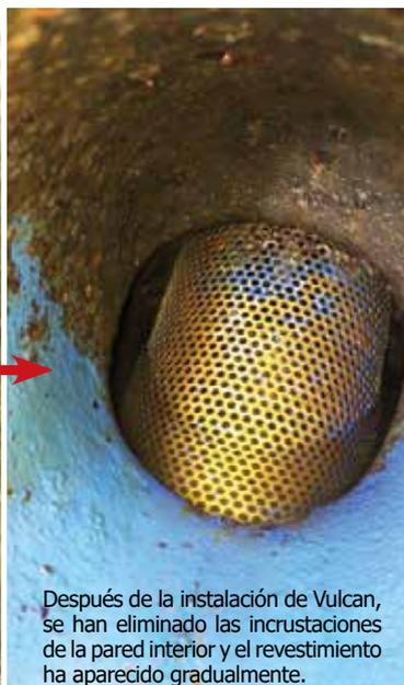
Después de la instalación de Vulcan, se han eliminado las incrustaciones de la pared interior y el revestimiento ha aparecido gradualmente.
