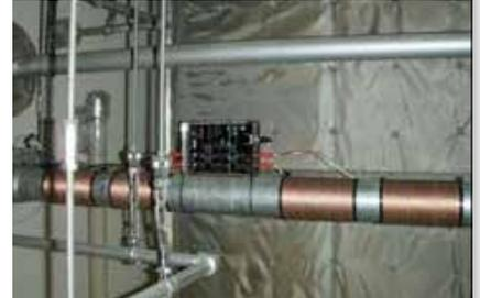
Se instaló un equipo Vulcan S25 en la tubería de distribución de agua de la torre de refrigeración C.
