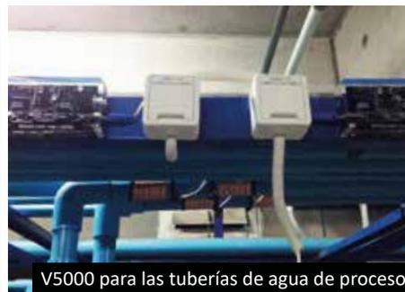
V5000 para las tuberías de agua de proceso
