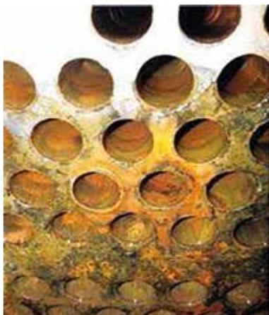
**Primera revisión: 4 de marzo de 2014.** Las placas de los tubos del intercambiador de calor fueron removidas para revelar la superficie interior de los tubos de cobre. Dado que estos tubos se habían limpiado recientemente a mano, prácticamente no había incrustaciones, como se puede apreciar en esta foto.
