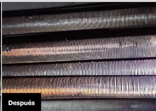
No se realizó una limpieza de las aletas antes de instalar el equipo Vulcan S25. 10 meses después, se habían eliminado los depósitos calcáreos más duros entre las aletas y algunas partes se observaban limpias, incluso revelándose el color original del tubo de cobre. Con Vulcan ha mejorado la calidad de agua, ahorrándose energía y costos de realización de limpiezas manuales.
