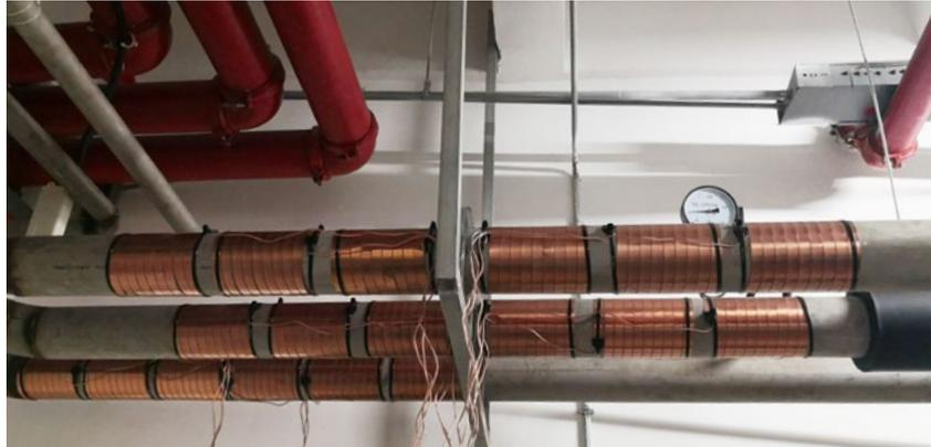
3 equipos Vulcan S100 instalados en la salida del depósito de expansión en el edificio de apartamentos 1
