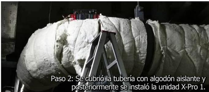
Paso 2: Se cubrió la tubería con algodón aislante y posteriormente se instaló la unidad X-Pro 1.
