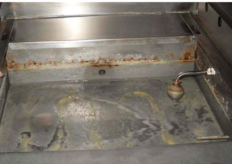
Antes de instalar Vulcan: en la bandeja se aprecia el calcio endurecido y las tuberías socavadas.
