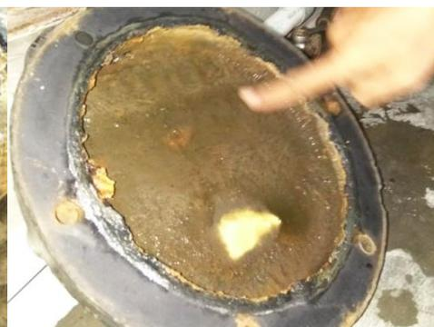
Interior del intercambiador de calor. El recubrimiento del condensador ha perdido toda la escala que tenía antes. (El punto de luz en la parte inferior es reflejo de la luz)
