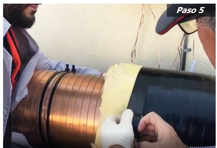
Para terminar, se cubren por completo las bandas impulsoras con aislante para protegerlas del exterior.
