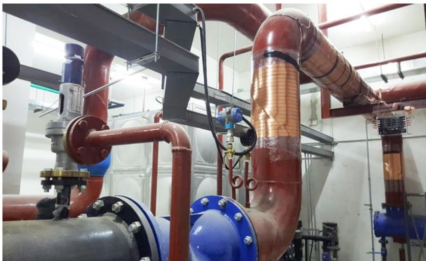
Vulcan S350 se instaló en el sistema de calefacción en la zona alta de la estación para el intercambio de calor.
