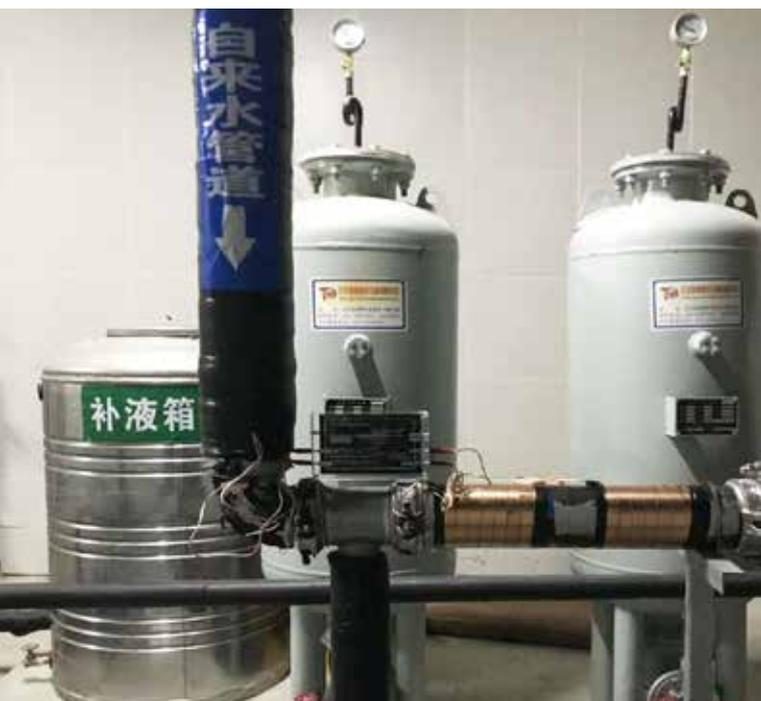
Vulcan S25 se instaló delante del intercambiador de calor para resolver problemas de incrustaciones en intercambiadores de calor, bombas, depósitos de agua, duchas y en todo el sistema de tuberías.
