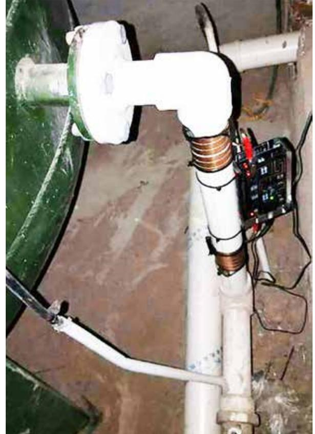
El Vulcan 5000 se instaló en la tubería principal de agua en el centro de baño.
