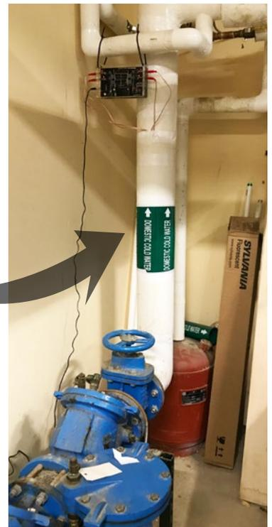
Paso 2: se instaló el equipo S25 en el conducto de agua y se cubrió con la capa protectora
