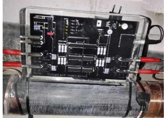
Vulcan S25 fue instalado en la tubería principal de agua para 132 apartamentos
