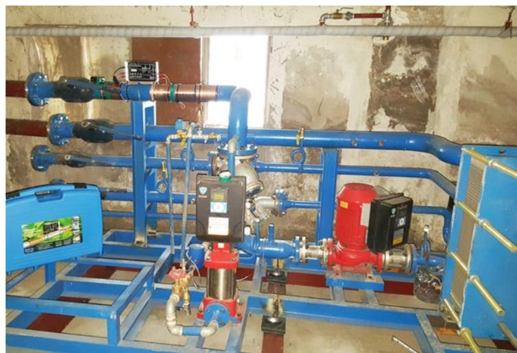
Vulcan S25 se instaló en la entrada de agua del sistema de calefacción del edificio 131.
