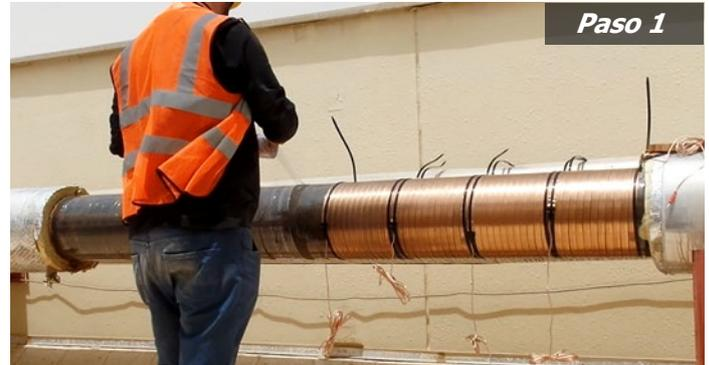
Primero se enrolla una película de plástico alrededor de la tubería para proteger las bandas impulsoras contra la condensación.
