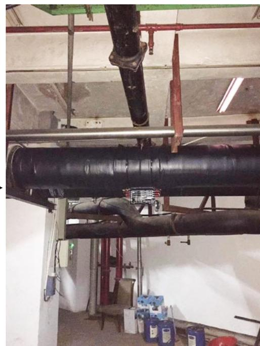
**Paso 2:** Se envolvió la tubería con material aislante y luego se instaló la unidad Vulcan S350
