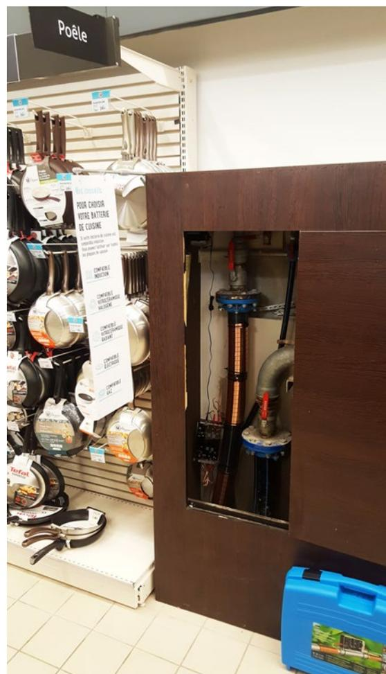
Se instaló Vulcan S25 en la tubería de agua principal para tratar todo el edificio.
