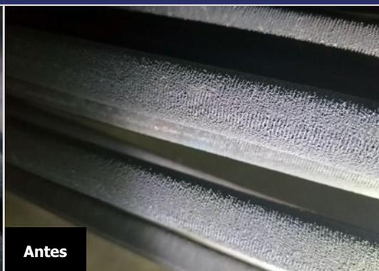
La dureza de las incrustaciones de cal entre las aletas afectaba la eficiencia de la transferencia de calor y la oxidación ocasionaba problemas en el agua.
