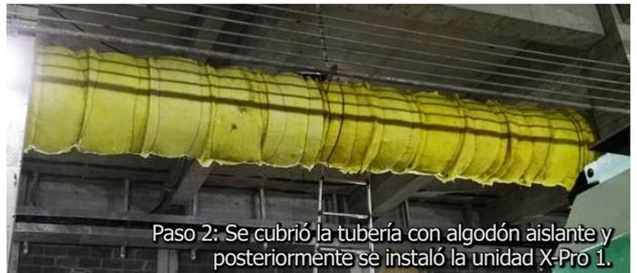
Paso 2: Se cubrió la tubería con algodón aislante y posteriormente se instaló la unidad X-Pro 1.
