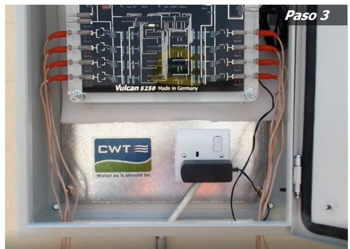
El equipo Vulcan S250 se conecta a las bandas impulsoras (este equipo se instaló en una caja al exterior para protegerlo de la humedad).
