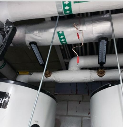
Se instaló Vulcan S10 en la recirculación del agua caliente, situada en la planta número 27. Antes de instalar el equipo Vulcan se procedió a cubrir las bandas impulsoras para evitar la condensación.
