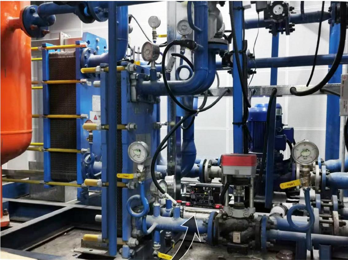
Vulcan S10 reemplaza los productos químicos de inhibición de la cal con el fin de prevenir la formación de depósitos calcáreos en la placa del intercambiador de calor de nuestros circuitos de agua caliente.
