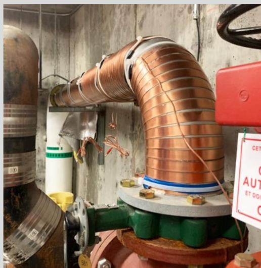
Las bandas impulsoras del equipo Vulcan S150 fueron instaladas en la tubería de entrada del agua, de 8 pulgadas.
