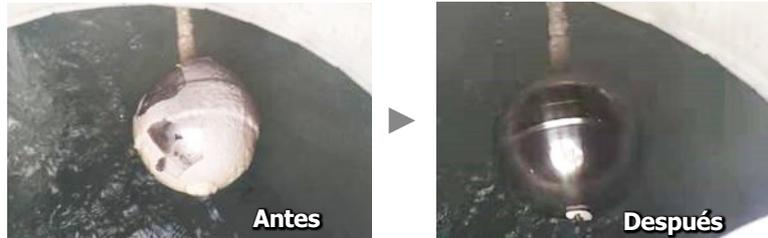
3. Después de 3 meses de la instalación, limpiamos el tanque de agua caliente, y descubrimos que se había eliminado gran cantidad de incrustaciones. La foto de abajo muestra las incrustaciones extraídas del depósito de agua. Además, la eficiencia de la transferencia de calor del sistema solar mejoró significativamente y el rendimiento se ha mantenido casi igual que al principio de la instalación de Vulcan.
