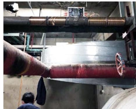
Vulcan S25 instalado en una tubería de cobre DN80.
