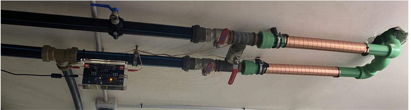
Vulcan S10 En el tubo del depósito de agua Ø 63 mm
