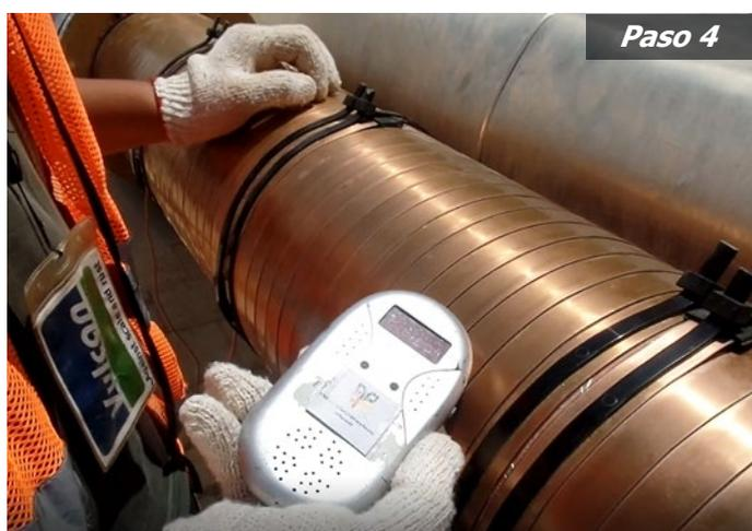
Con un detector de impulsos se comprueba el funcionamiento de Vulcan.
