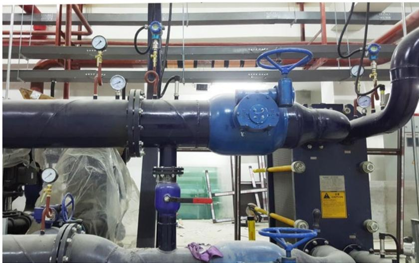
El Vulcan S150 se instaló en el sistema de calefacción en la zona baja de la estación para el intercambio de calor.
