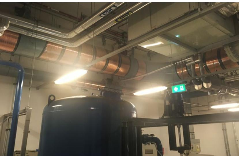
Los equipos Vulcan S250 y X-Pro 1 se instalaron en las tuberías principales de retorno del condensador.
