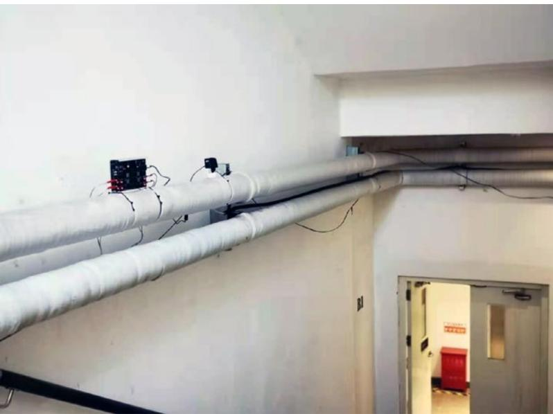
Se instaló un equipo Vulcan S25 en la tubería principal que pasa sobre la escalera y que va a la bomba de calor.
