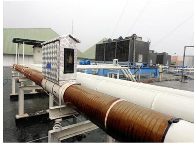
Vulcan S500 se ubicó dentro de una caja de aluminio y se instaló en la tubería principal de una torre de refrigeración en el centro comercial Karawaci.
