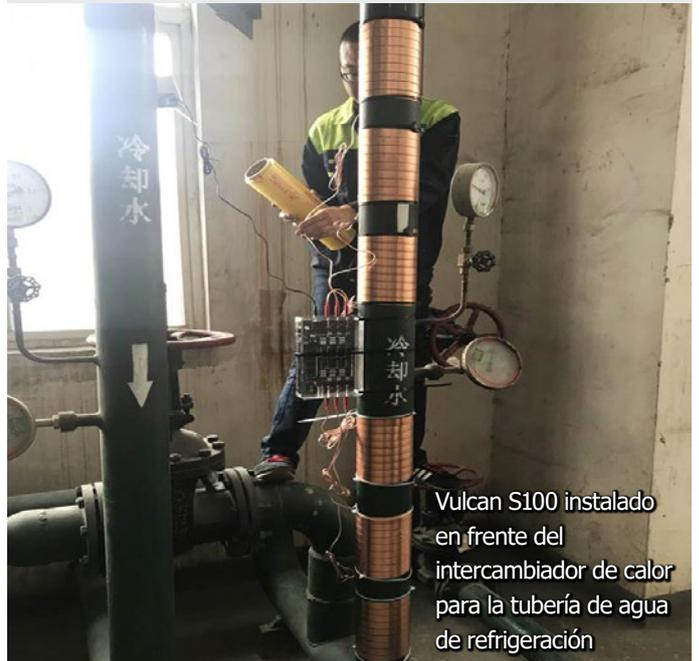
Vulcan S100 instalado en frente del intercambiador de calor para la tubería de agua de refrigeración
