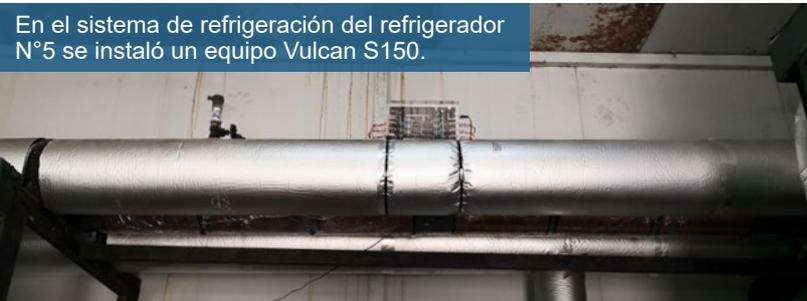
En el sistema de refrigeración del refrigerador N°5 se instaló un equipo Vulcan S150.
