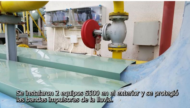
Se instalaron 2 equipos S500 en el exterior y se protegió las bandas impulsoras de la lluvia.
