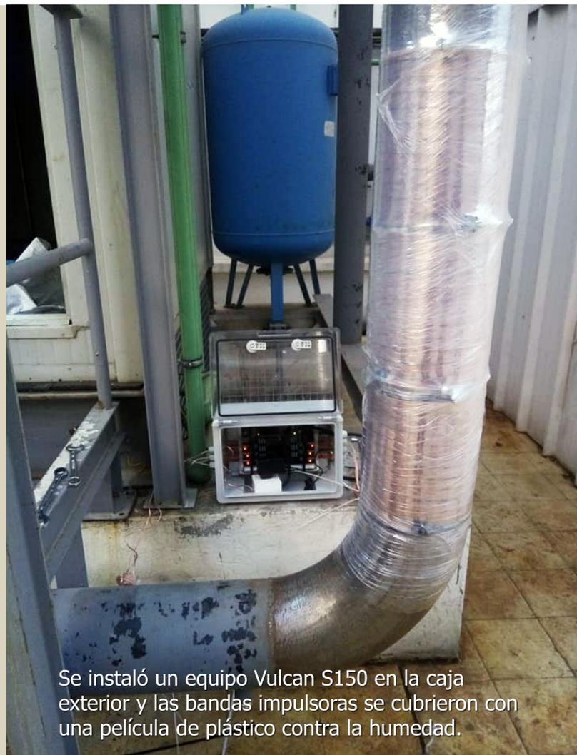
Se instaló un equipo Vulcan S150 en la caja exterior y las bandas impulsoras se cubrieron con una película de plástico contra la humedad.
