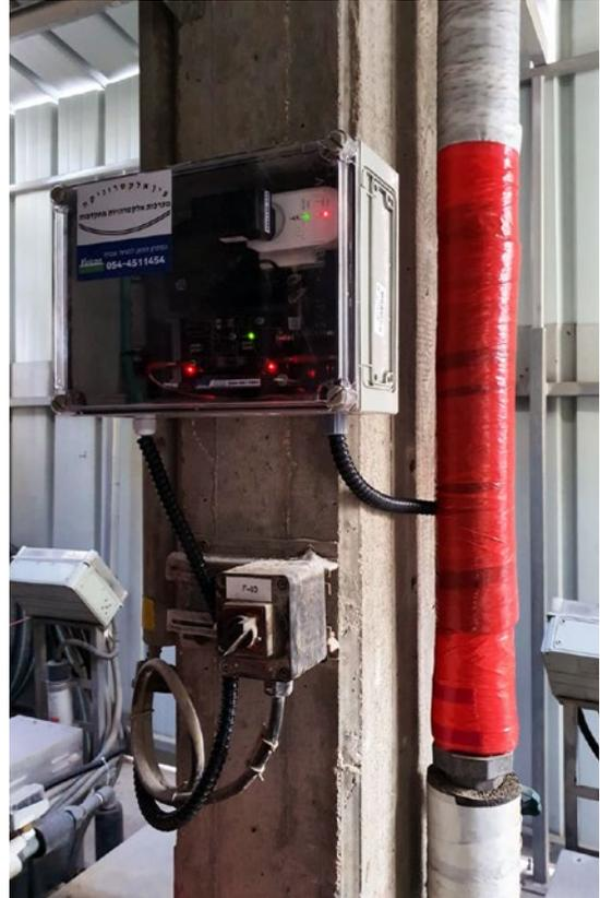
Se instaló un equipo Vulcan 5000 en la tubería de retorno del agua de la calefacción.
