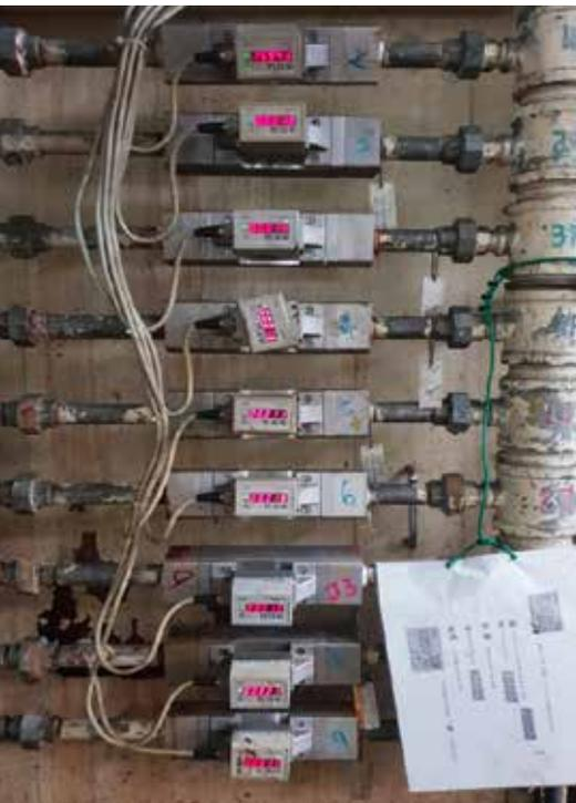
Existen 9 tuberías secundarias pequeñas que cuentan con medidores de agua. Estos fueron instalados para asegurar una tasa de flujo estable. Si el caudal disminuye, se produce un disfuncionamiento en la máquina de temple por inducción, por lo que era necesario limpiar las tuberías manualmente cada 2-3 meses.
