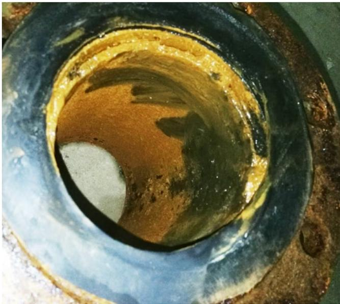
La cal se puede limpiar fácilmente, y la tubería cuenta con una superficie lisa
