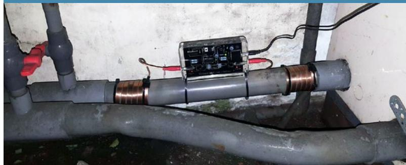
Vulcan S10 instalado en el tubo del agua de circulación de 3".
