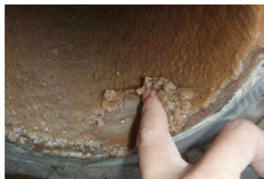
Los depósitos calcáreos en la tubería de circulación también pueden retirarse pasando un dedo.
