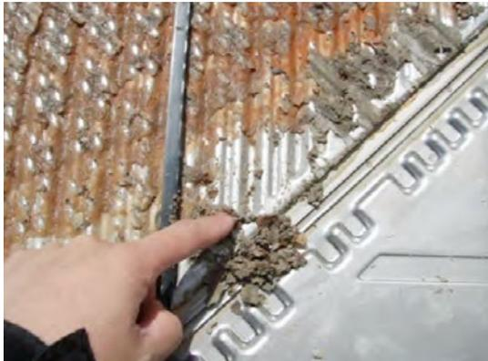
Se ablandan los depósitos calcáreos en el intercambiador de calor de placas.
