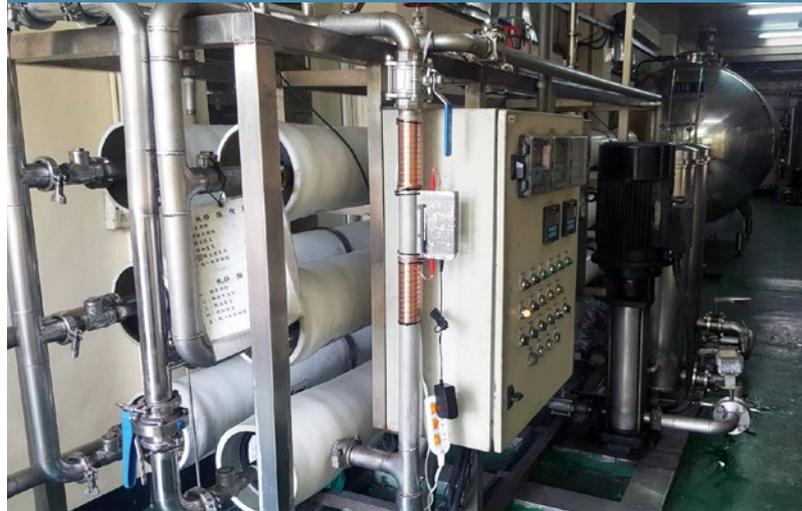
Vulcan S25 instalado en el tubo del agua de circulación de 4".
