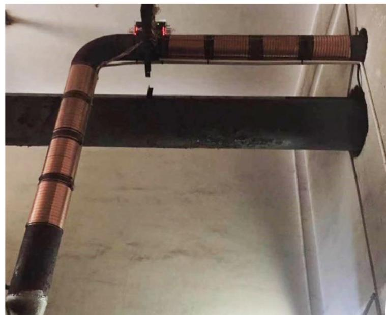
Se instaló Vulcan S250 en la tubería de agua de refrigeración por circulación para los equipos de tejido.
