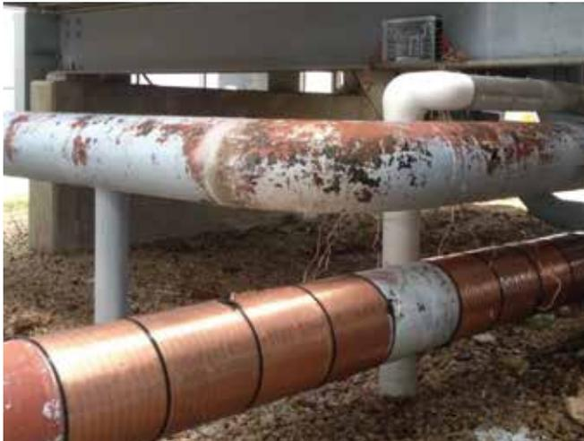
Vulcan S250 instalado en una línea de 10 pulgadas de diámetro que alimenta las torres de enfriamiento gemelas (CT-1 y CT-2)
