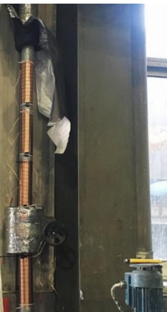
Vulcan S25 se instaló en la tubería principal de las torres de refrigeración de la fábrica de moldes.
