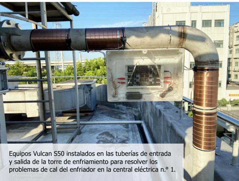
Equipos Vulcan S50 instalados en las tuberías de entrada y salida de la torre de enfriamiento para resolver los problemas de cal del enfriador en la central eléctrica n.º 1.
