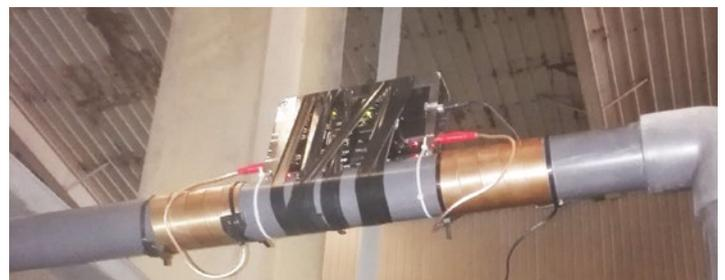
Vulcan S10 instalado antes de la membrana de ósmosis inversa.
