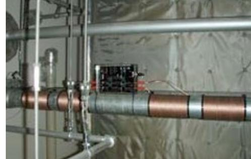
Se instaló un equipo Vulcan S25 en la tubería de distribución de agua de la torre de refrigeración C.
