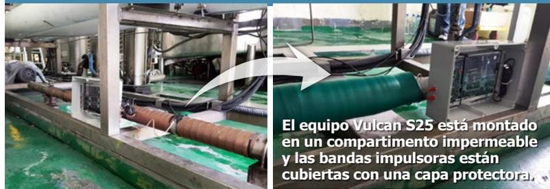
El equipo Vulcan S25 está montado en un compartimento impermeable y las bandas impulsoras están cubiertas con una capa protectora.
